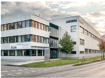
Außenansicht Betriebsgebäude in Klaus
