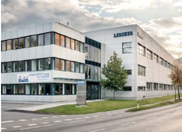
Außenansicht Betriebsgebäude in Klaus
